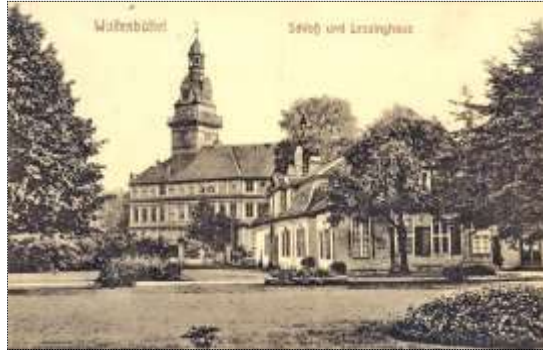
Schloss Wolfenbüttel: in diesen Räumen befand sich die Höhere Mädchenschule und hier wurden zukünftige Lehrerinnen ausgebildet.
