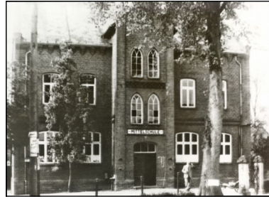
Mittelschule Freiburg (Elbe). Schulgebäude 1949.
