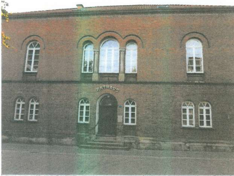
Ein mächtiger zweigeschossiger Backsteinbau mit symmetrisch geordneter Fensterachse im Erd- und Obergeschoß im Rundbogenprofil und sog. Drillingsfenster über dem Eingang. Der Eingang selbst im Rundbogenprofil. Die Fassade wurde durch einen durchlaufenden Backsteinsims aufgelockert.
