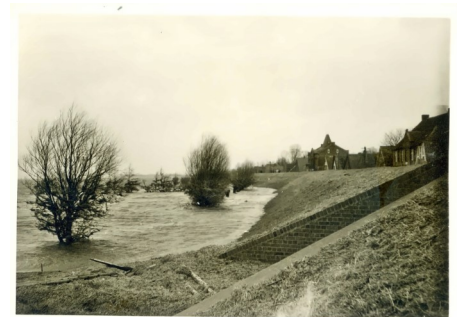
Deichlücken waren eine gefährliche Schwachstelle in den Deichen.
